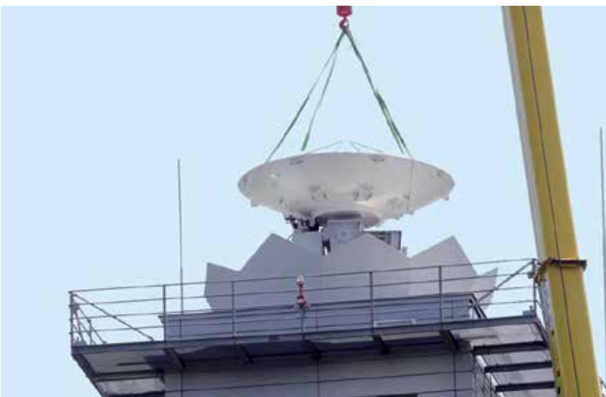
Installation eines Wetterradargerätes auf der Turmspitze - noch fehlt die schützende Kuppel, das Radom ▼
